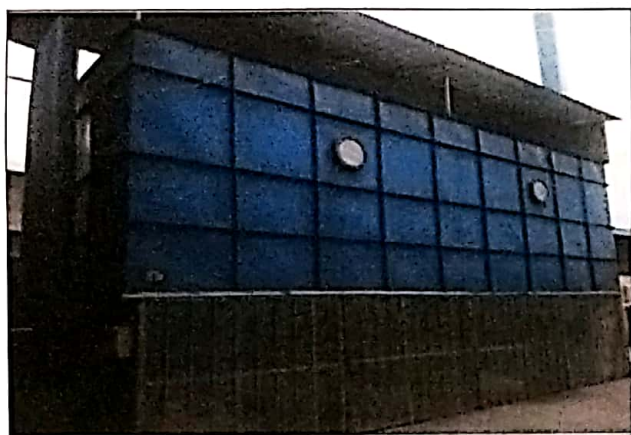
中频电炉袋式除尘器
